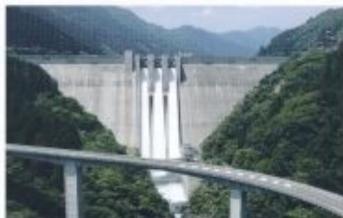
滝沢ダム(水資源機構)
