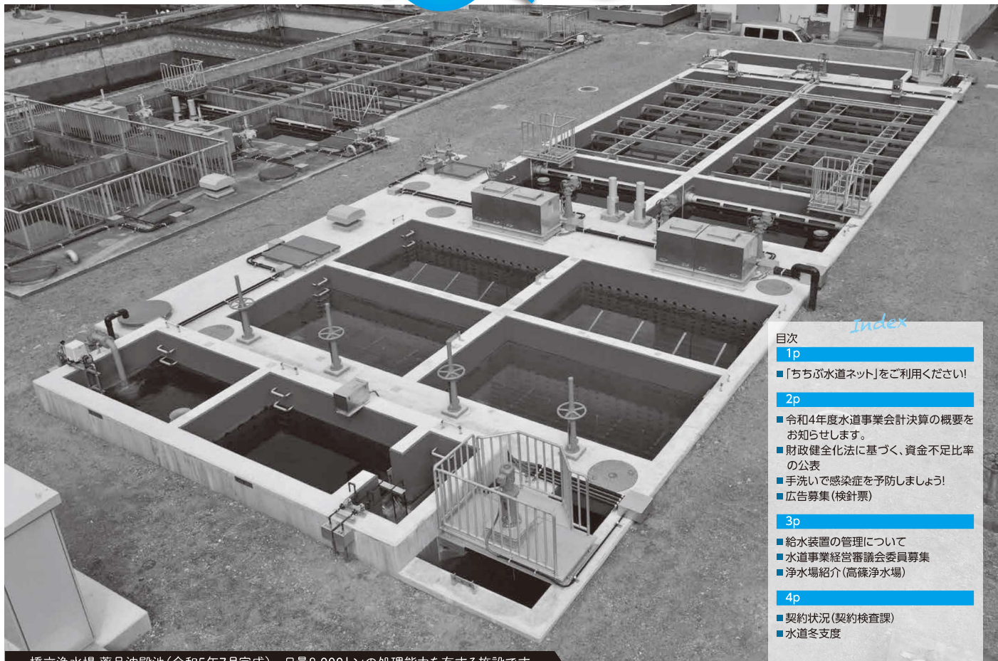
橋立浄水場 薬品沈殿池(令和5年7月完成) 日量8,000トンの処理能力を有する施設です。
