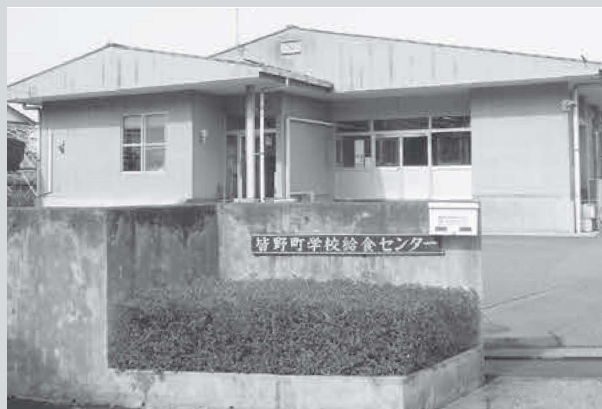
現在の皆野町学校給食センター
